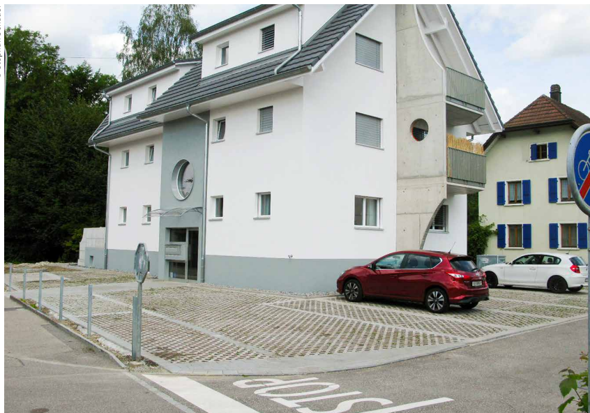
Das kann es nicht (mehr) sein: Einhaltung der Grünflächenziffer durch flächendeckenden Einbau befahrbarer Rasengittersteine... Vorbildliche Umgebungsgestaltung ist zum Glück im Aufwind (vgl. «Der Wind hat gedreht»).
