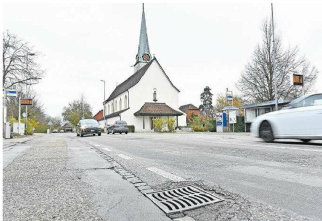
Kein Platz für Velostreifen: Die Dorfstrasse in Neuendorf.
