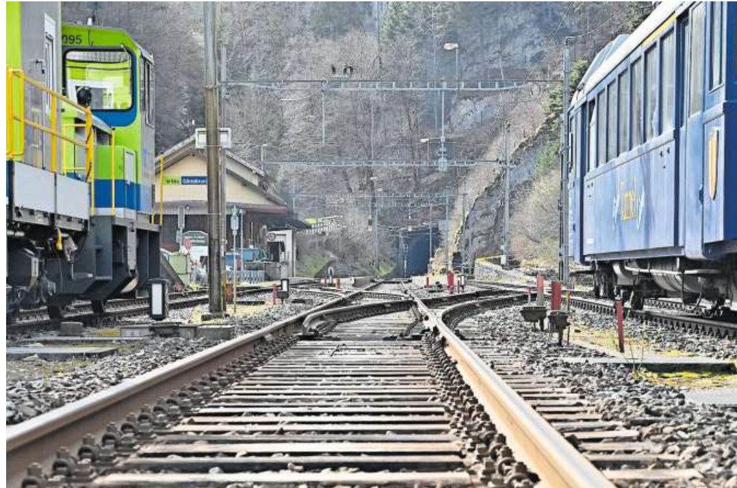
Das Nordportal des Weissensteintunnels beim Bahnhof Gännsbrunnen.
