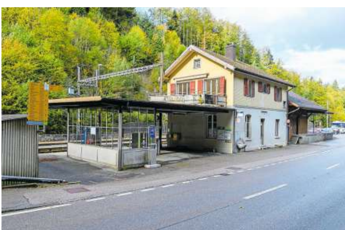
Auch der Bahnhof Gänsbrunnen soll erneuert werden. Hier entsteht ein neuer gedeckter Perronbereich.
