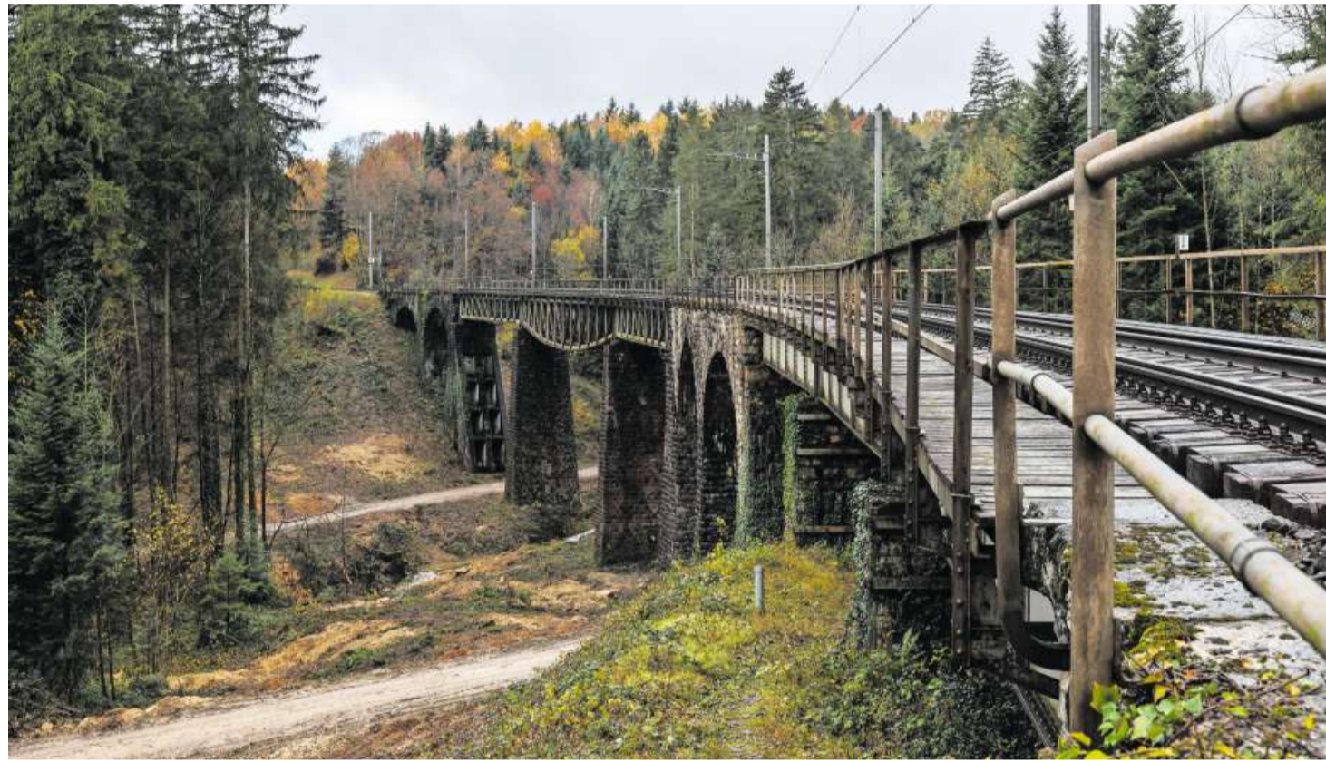
Beim Geisslochviadukt wurde eine Fläche von knapp 6000 Quadratmeter Wald gerodet.
