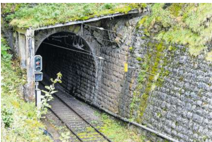
Nach mehr als hundert Jahren muss der Tunnel saniert werden. Er ist während der Arbeiten gesperrt.
