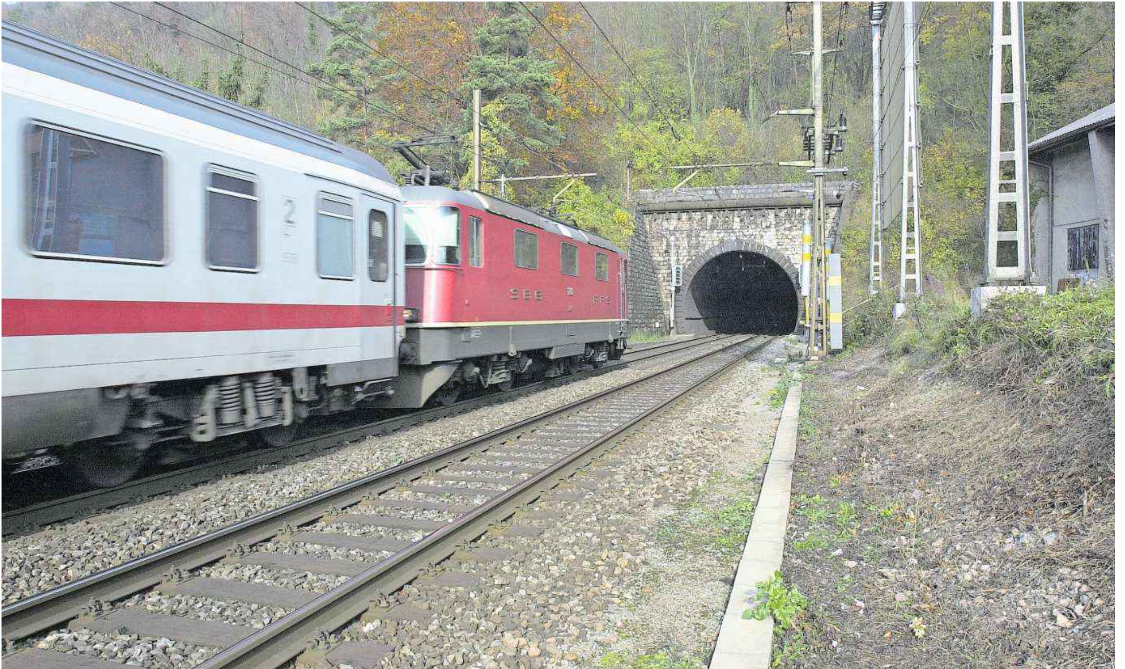
Der Hauenstein-Basistunnel wird ab 2023 für vier Jahre saniert. Wie schon während der Bauzeit 1912 bis 1916 könnte im Gebiet Tripolis der Installationsplatz eingerichtet werden.
