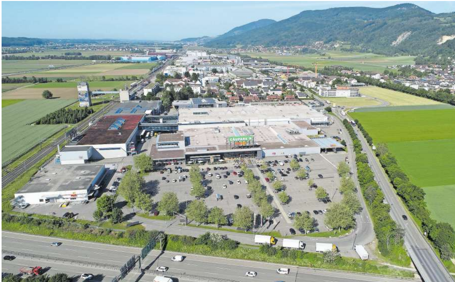
Soll abgerissen und neu aufgebaut werden: der Gäupark in Egerkingen. Noch ist aber die Einsprache des VCS hängig. Bild: Bruno Kissling
