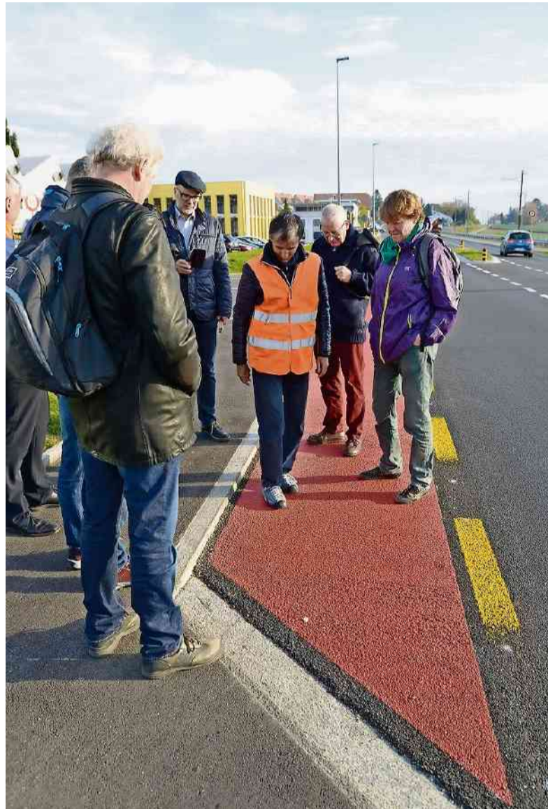
Ein sechs Zentimeter hoher und schräg gestellter Randstein. Die Diskussionen waren genau so kontrovers wie die Bedürfnisse der diversen Nutzergruppen.
