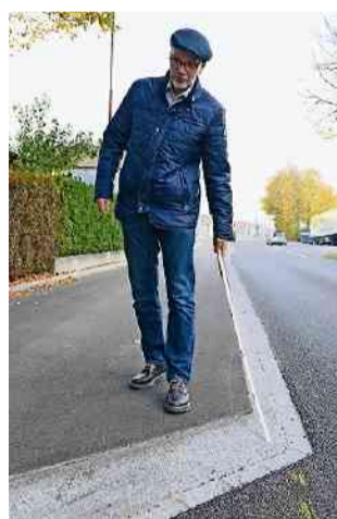
Ein sechs Zentimeter hoher und schräg gestellter Randstein. Die Diskussionen waren genau so kontrovers wie die Bedürfnisse der diversen Nutzergruppen.
